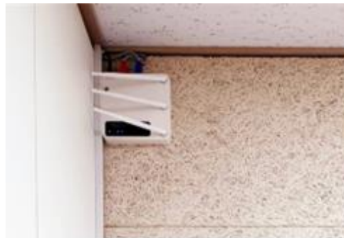
방음벽 설치, 인터넷 공유기 유선 연결
